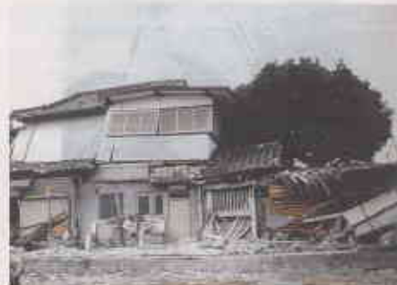
2階を増築した住宅
