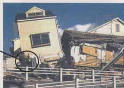
1階部分は完全に倒壊(左写真の全景)
