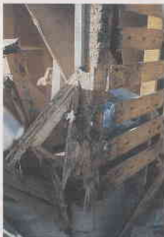
柱脚部や土台のシロアリ被害
