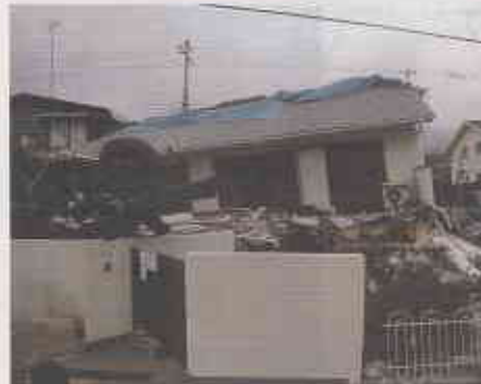
倒壊した住宅
